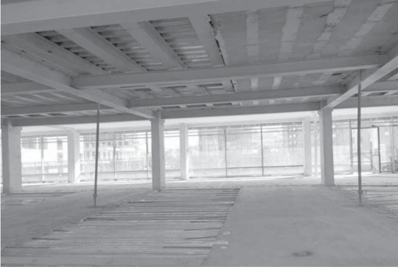
ŞEKİL 9.10: Güçlendirilmiş döşeme
